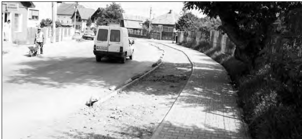
Pentru medieșeni, 2011 este anul șantiierelor stradale
